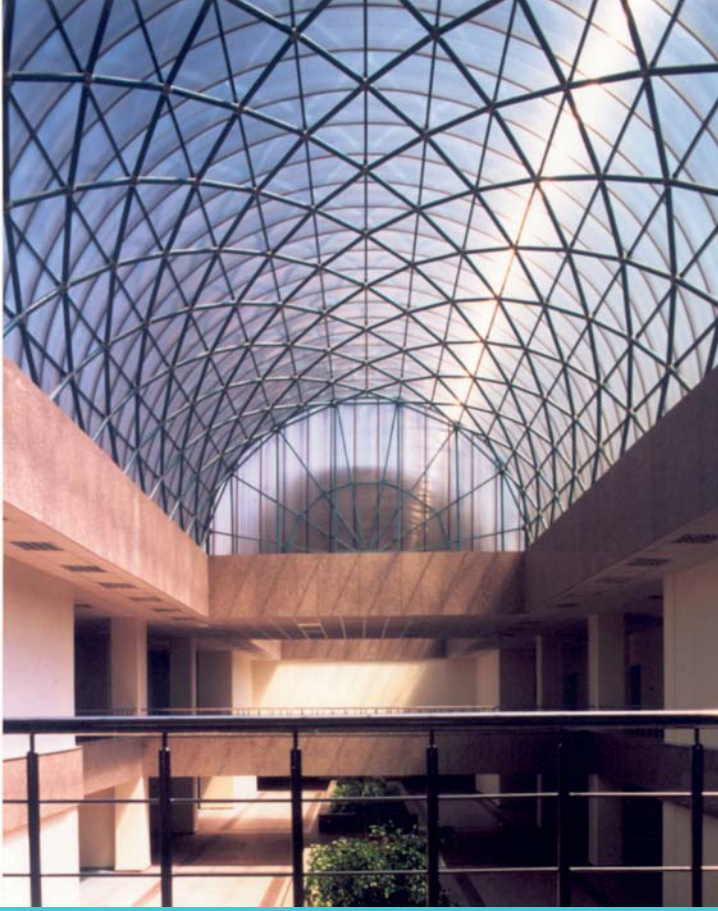
Tuzla Kafkale Spor Kompleksi, Türkiye - Uygulama: Alter İnşaat
