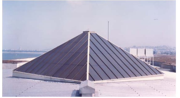
İş Merkezi, Türkiye - Uygulama: Sonart Yapı
