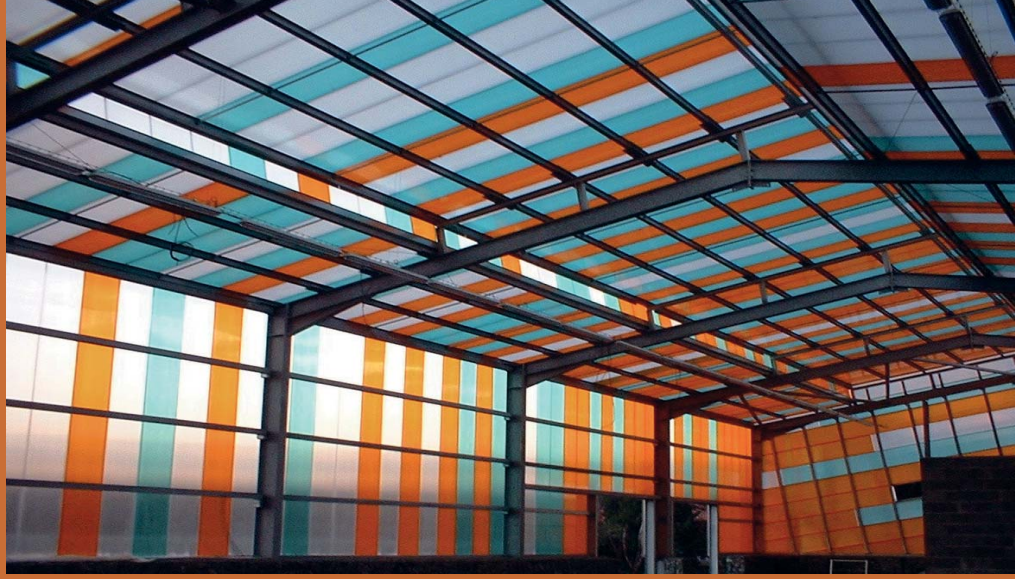
Çevre Bakanlığı Teknik Merkezi, Anglet, Fransa - Mimarlar: DL & Associates
